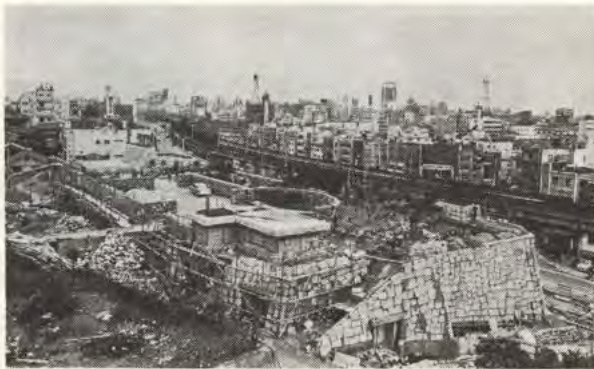
市営駐車場の完成を急ぐ花隈城周辺…昭和44年2月撮影
